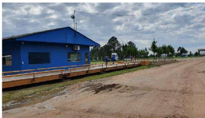
Figura 9. Estação de Transbordo.
