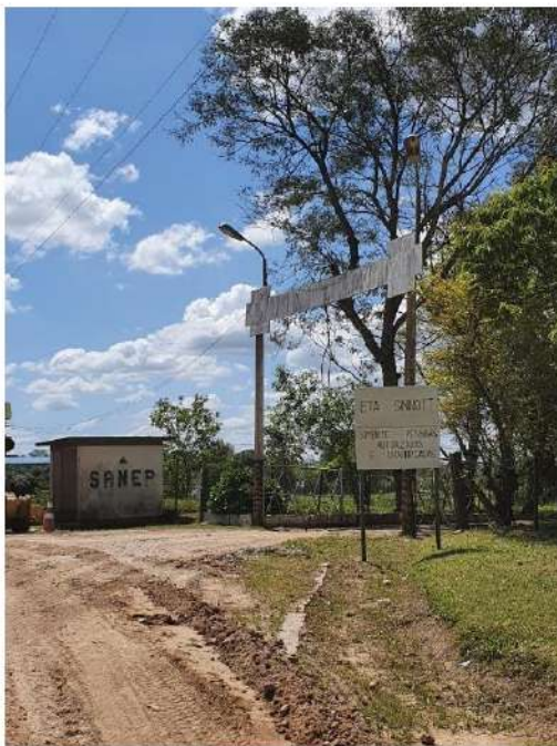
Figura 11. Entrada para a ETA Sinotti.
