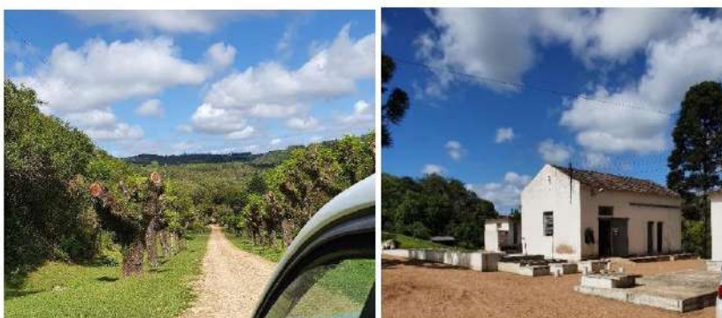
Figuras 13 e 14. Entrada para a ETA e ETA Quilombo, respectivamente.
