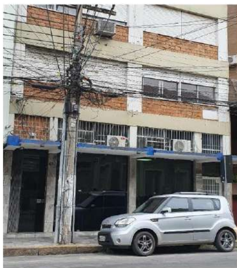
Figura 1. Sede Administrativa do Sanep.
